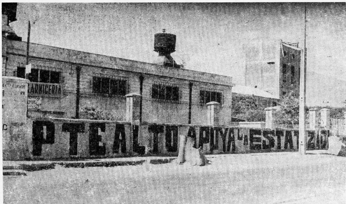
LA POBLACION DE PUENTE ALTO, donde se levanta la planta de la Cia. Manufacturera de Papeles y Cartones, apoya la estatización de la industria, entendiendo que el papel y la celulosa deben pertenecer a todo el pueblo y no a una minoría oligárquica.
