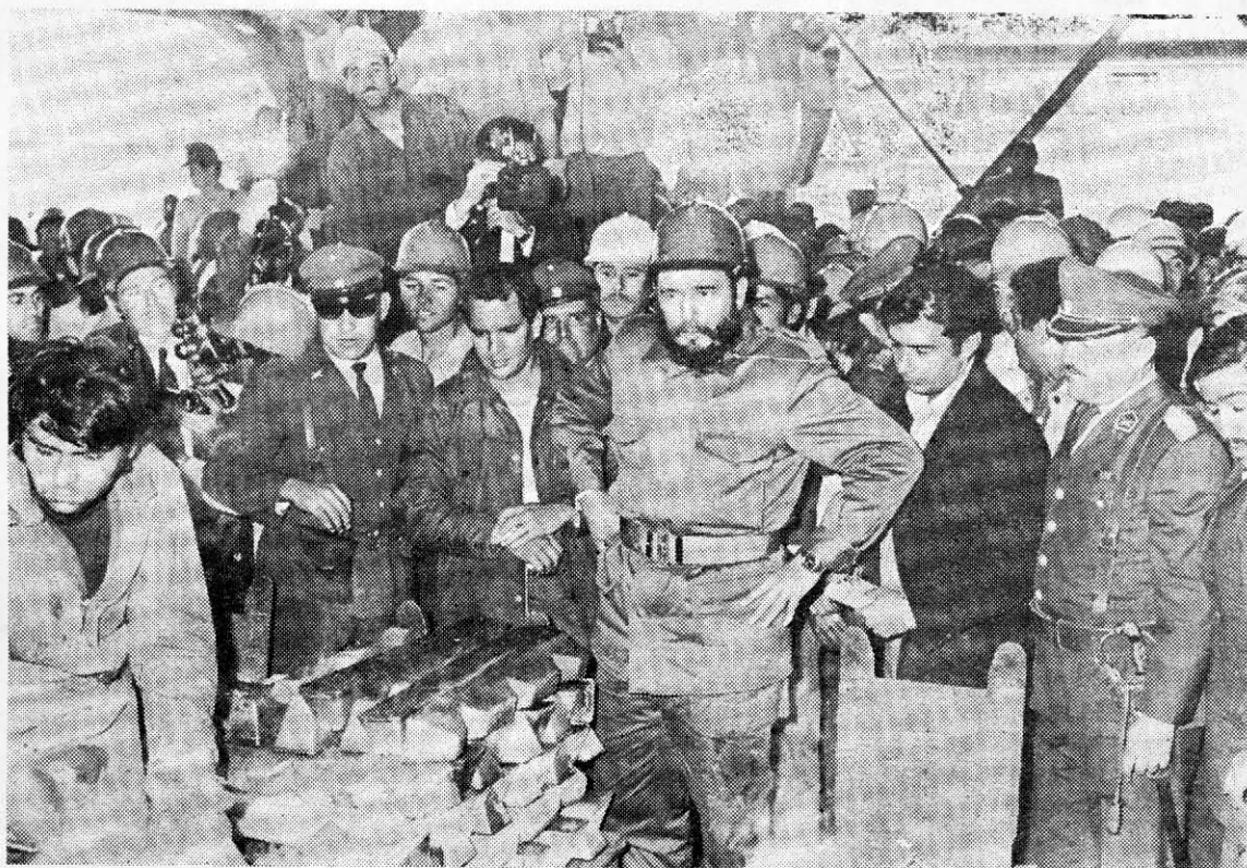
EN EL INTERIOR DE LA FUNDICION de Ca etones (mina de El Teniente que perteneció a la Kennecott Copper), el Comandante Fidel Castro inquire detalles sobre la producción.
